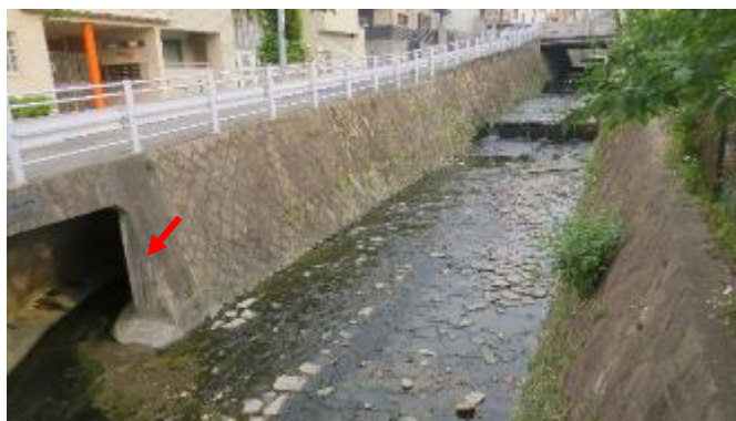
図 8. 天井川上流部と雨水トンネル（矢印）
