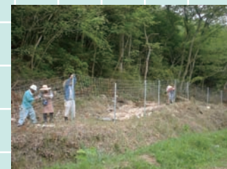
金網柵の設置
