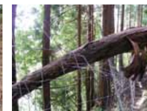
倒木のため破損した柵
