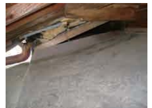
屋根裏につながる隙間
